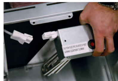
В стандартную комплектацию HERU® входит встроенный электрический канальный воздушнонагреватель
